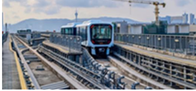
شكل ١٠٣. مشروع القطار الكهربائي الخفيف (LRT)
